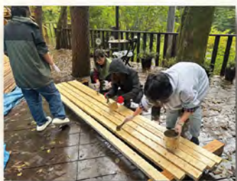
10月20日 防腐剤塗り
