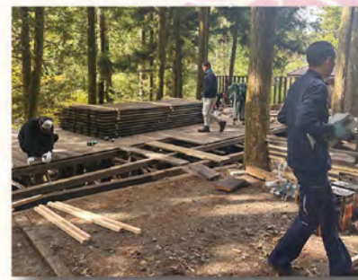
11月1日 板張り作業
