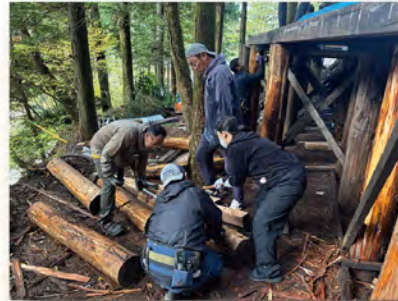
11月4日 基礎造り
