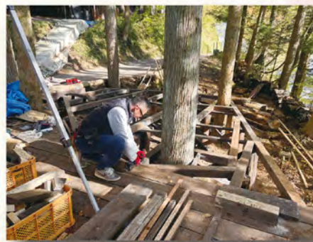
11月8日 板張り作業
