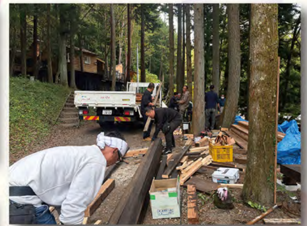
10月27日 基礎造り
