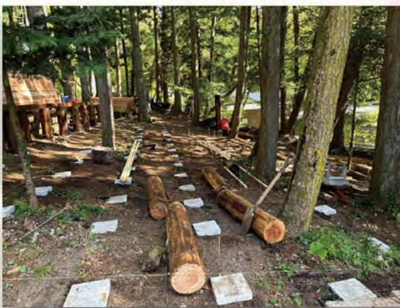
10月13日 基礎造り
