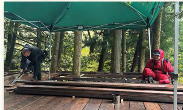
10月29日 板張り作業
