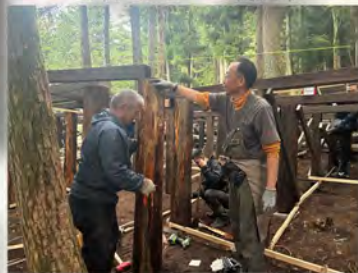
10月27日 基礎造り
