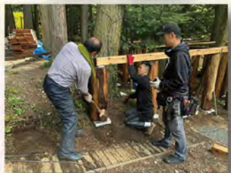
10月21日 基礎造り
